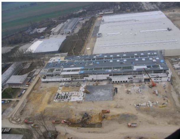
Rysunek 3. Kompleks obiektów produkcyjno-magazynowych w Strzelcach Opolskich w trakcie realizacji
